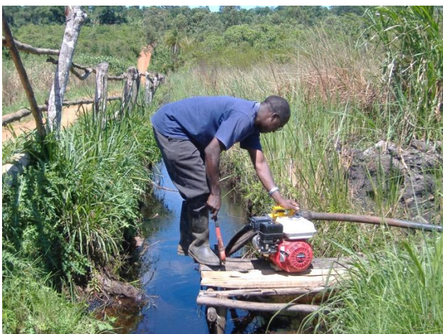
Wasserversorgung; Emmanuel mit Pumpe am Bach bei den Fischteichen. Die Leitung führt zur Zisterne im Kinderheim Kamukongo.
