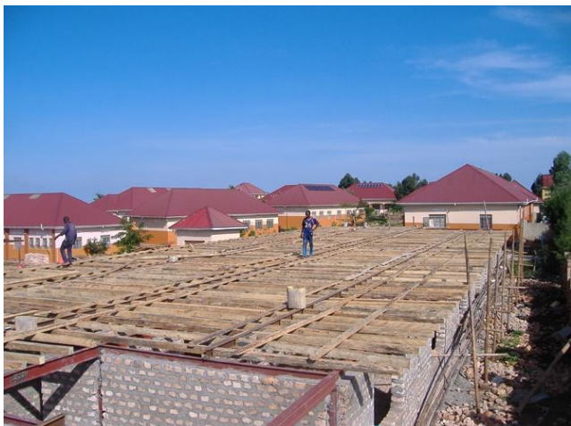
Weiterbildungszentrum Kitamba, Neubau Dormitory
