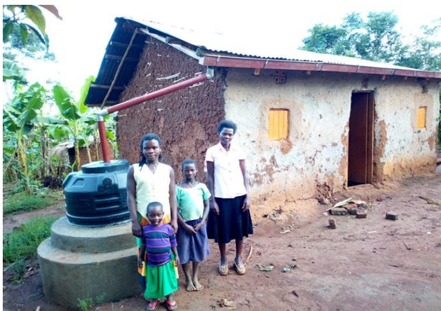
Wasserprojekt für ärmste Familien; Installation einer Dachrinne und Wassertank für Regenwasser.
