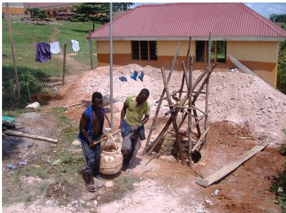
Brunnenschacht im Weiterbildungszentrum Kitamba. Der tiefe Schacht wurde in Handausschachtung und mit einer einfachen Handseilwinde ohne den Einsatz von Maschinen gegraben und mit gebrannten Ziegeln ausgemauert.
