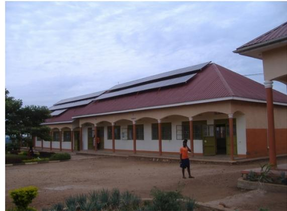
Zentrale Solaranlage auf dem Dach der Lehrwerkstätten für Elektriker und Mechaniker. Hinter dem Haus steht in einem kleinen Schuppen geschützt ein zuschaltbarer Generator für die Notstromversorgung.
