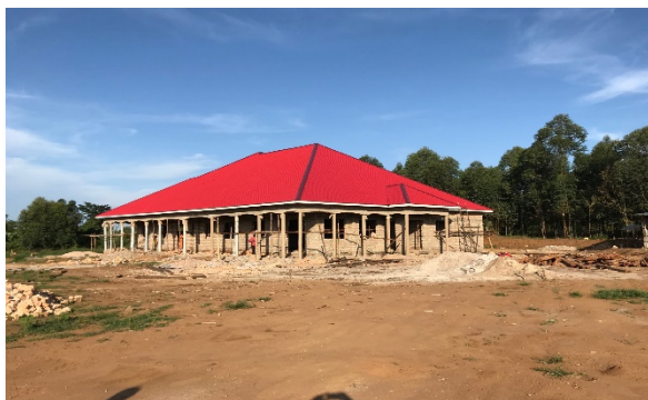
Das Dach des neuen Verwaltungsgebäudes für das Lager- und Distributionszentrum in Birinzi ist bereits fertig.
