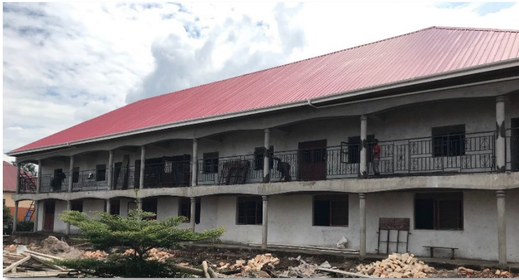
Eines der beiden neuen Dormitorien für die Kitamba Secondary School – die Fertigstellung ist noch vor Jahresende geplant.
